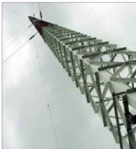
Eine der 360 m hohen Sendeantennen in Donebach
