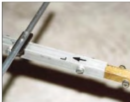
Verschraubung der Tragrohrhälften mittels zweier Messingstreifen
