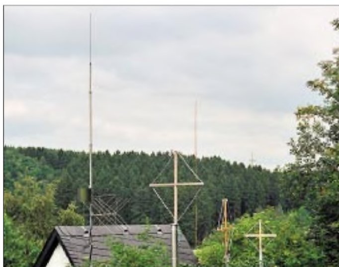
Bild 1: Ein Teil der Sferics- antennenanlage von DG9WF; zwischen den Rahmenantennen erkennt man die Stabantenne zum Empfang der vertikalen elektrischen Feldkomponente.
