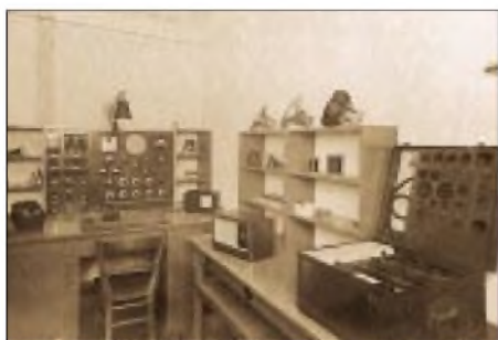
Meß- und Reparaturraum im Hinterzimmer des „Radio-Ladens“
