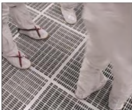
Produziert wird im Reinraum. Die Luft wird ständig erneuert und fließt dabei durch Belüftungsraster im Boden.
