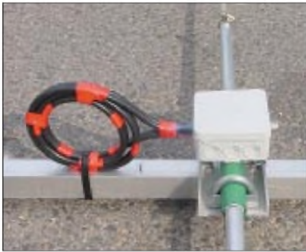
Bild 8: Fertig montiertes Mittelstück in der Antenne
