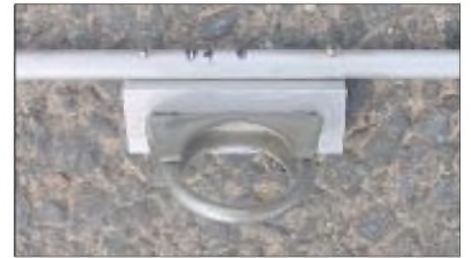
Bild 10: Haltewinkel mit Auspuffschelle für Tragrohre aus Rundmaterial
