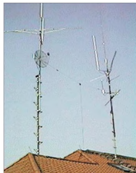
DB0GV: 23-cm-Antennen zu DB0BOS und DB0ASF
