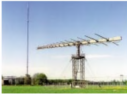
Drehbare Logperiodic für Kurzwelle, im Hintergrund der 320 m hohe Antennenträger für die UKW-Antennen
