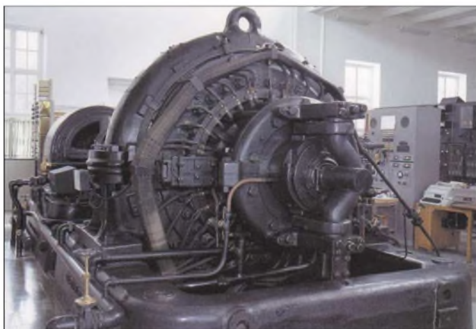
Bild 1: Maschinensender von Grimeton nach der Bauart des schwedischen Konstrukteurs und Erfinders E. Alexanderson. Der Sender wurde 1924 zur Herstellung von Telegrafieverbindungen nach Amerika gebaut.
