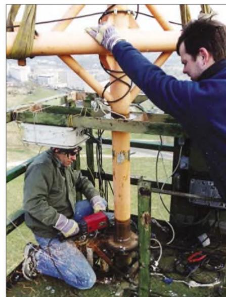
Rainer, DL1AUZ, und Steffen, DL4ALB, zersägen das Standrohr der 3-Ele.-40-m-Quad im 30 m Höhe, damit ein neues Getriebe montiert werden kann.
