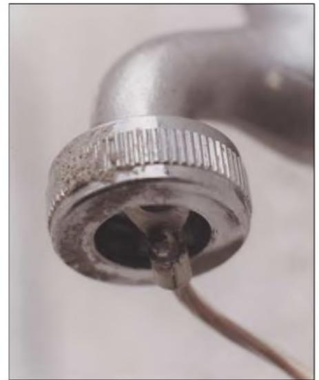
**Bild 4:** Ein schneller Weg zur Verbindung des Erdungskabels mit dem Wasserleitungsnetz, wenn es denn aus Metall ist ...
