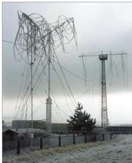
Die größten Stürme haben den z.T. 30 m hohen Antennen in den vergangenen Jahren nichts mehr angetan, aber beim Thema Eis ist alles zu spät! Während sich die Multibandantennen für die Bänder 10 bis 20 m immer wieder selbst aufrichten, leidet die 40-m-Quad unter der hunderte Kilo schweren Last. Diese Antenne muss noch bis zum 12.7. repariert werden, ein großes Stück Arbeit!
