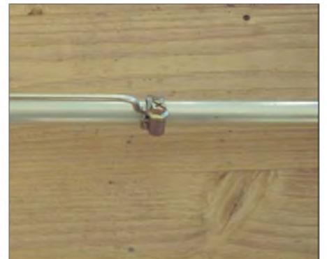
**Bild 8: Übergang der Phasenleitung zum Aluminiumrohr mittels Schlauchschele**
