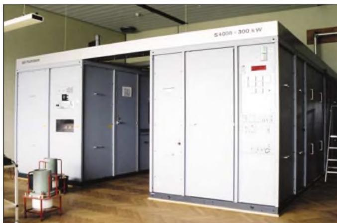
70 % sowie eine erhöhte Lebensdauer der Senderöhren ermöglichte. Rein äußerlich ist bereits zu erkennen, dass alle drei Sender aus dem gleichen Grundaufbau bestehen. Während der Langwellen- und der Mittelwellensender fest abgestimmt sind, können die Induktivitäten der acht abzu-
