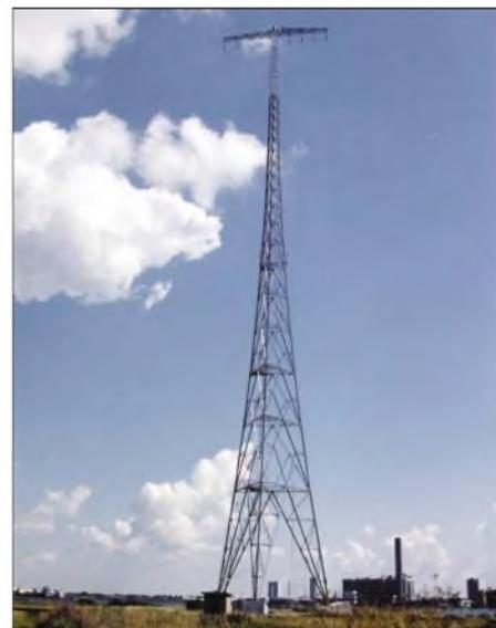
Passiv gespeister Antennenmast der Langwellenantenne
