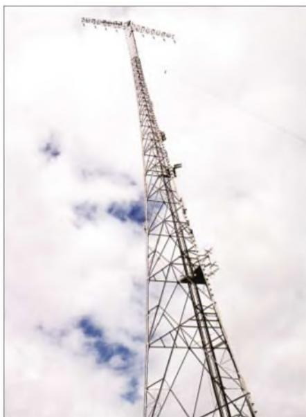
**Direkt gespeister Langwellen-Antennenmast nahe des Stationsgebäudes**
