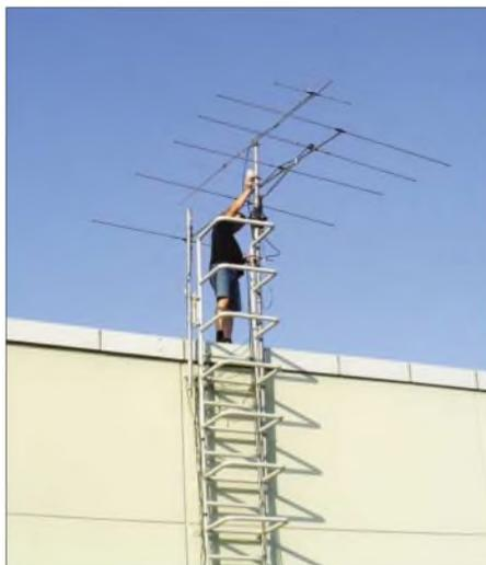
Montage des 5-Ele.-Beams für 6 m und der 9-Ele.-Yagi für 2 m
