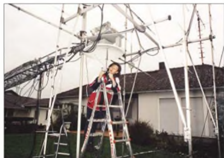
Cecilie, DK8ZP, bei der Montage der 10- und 24-GHz-Antennenanlage. Foto: DJ1KP
