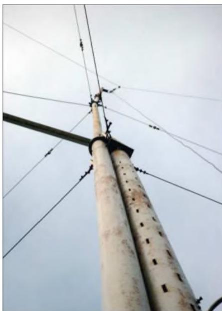
**Bild 3:** Schaden am Mast der 4-El.-40-m-Yagi
