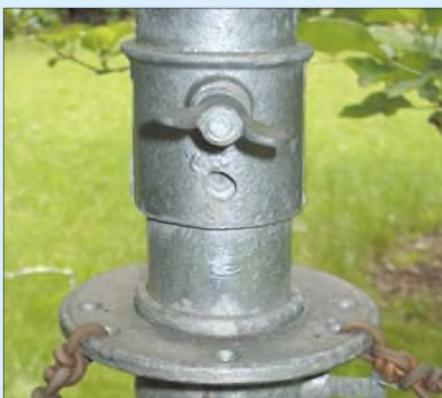
Jedes Mastsegment besitzt am Kopfende eine Aluminiumhülse. Sie dient als Auflage für den drehbaren Abspannung. Fotos: rd
