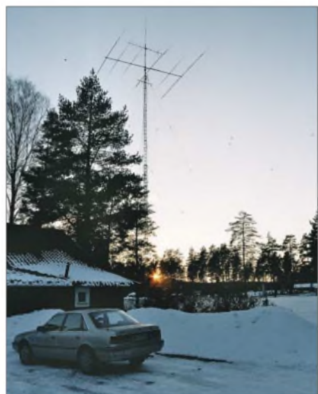
Morokuliens Radiostation: 25-m-Gittermast mit TH6DX für 20, 15 und 10 m
