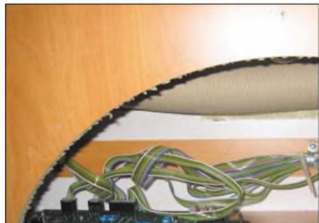
Länger gehts nicht: Kabelwirrwarr hinter dem Kontroll-Panel
