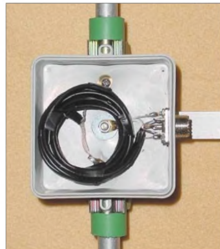
Bild 9: Anpassleitung als Kabeldrossel aufgewickelt
