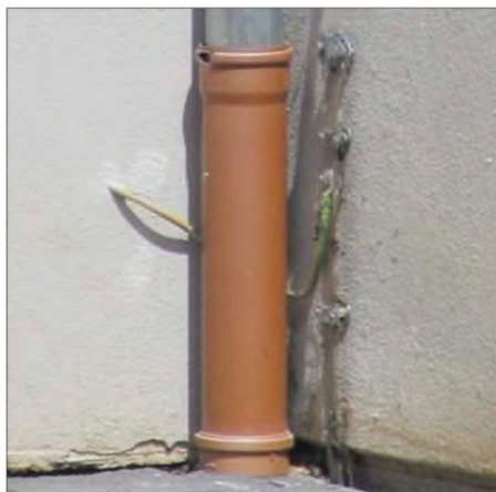
Bild 3: Hier mündet das Fallrohr in Kunststoffrohr, daher ist keine zusätzliche Isolierung notwendig. Rechts zu sehen ist der Anschluss des Fundamenterders, links das Kabel vom Antennenkoppler zum Fallrohr, der Anschlusspunkt ist auf der Rückseite.
