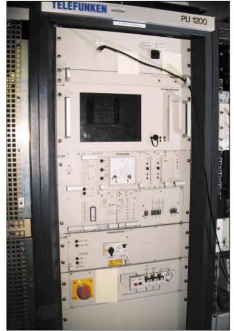
Steuerteil des von Telefunken hergestellten 1-MW-Senders TRAM 1000S
