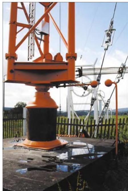
**Isolierter Mastfuß eines der vier 227 m hohen Antennenstrahler mit Funkenstrecke**
