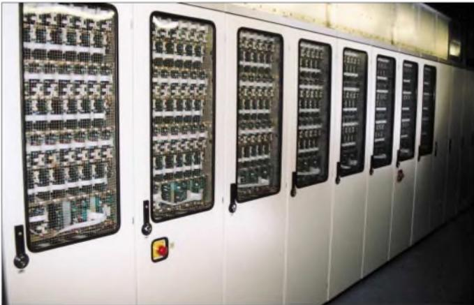
uneffektiver Betriebsweise der Senderöhren verbunden ist, ermöglicht dieser Transistorsender den wirtschaftlichen Betrieb innerhalb des gesamten Leistungsbereichs. Der Wirkungsgrad des Senders wird vom Hersteller mit 84% angegeben. Zum Erreichen dieses guten Ergebnisses trägt auch die seit etlichen Jahren zum Standard gehörende dynamische Amplitudenmodulation bei, die die Trägerleistung der Modulation anpasst.
