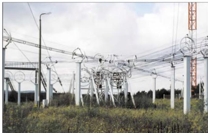
Anstelle der sonst verwendeten Aneinanderreihung mehrerer Leistungsstufen erreicht man die hohe Leistung durch das Zusammenschalten vieler Einzelbaugruppen. Jedes dieser Halbleiter-Leistungsmodule gibt bei einer Betriebsspannung von 210 V eine Ausgangsleistung von 1,3 kW ab. Die Hochfrequenzgänge der einzelnen Module werden induktiv ausgekoppelt und über Combiner zusammengefasst. Um die 1 MW zu erreichen, sind 768 Module erforderlich.
