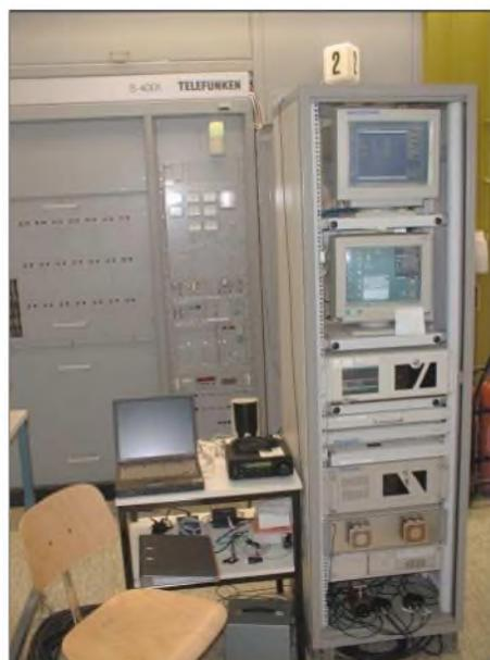
In diesem Teil der Anlage werden Sendungen in DRM-Technik aufbereitet und auf den Leistungsverstärker gegeben. Fotos: DL3PS (5), T-Systems (2)
