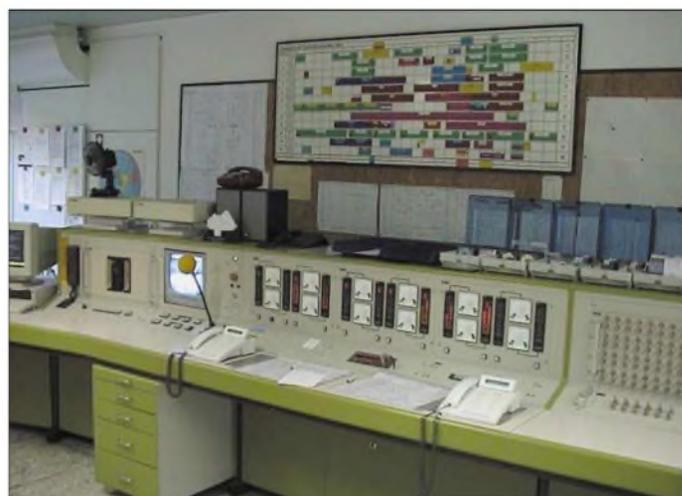
gen von etwa 100 W, so platzen die Sender in Jülich gleich mit dem tausendfachen in die weite Welt hinaus. Jeder der vorhandenen zwölf Kurzwellensender arbeitet typischerweise mit 100 kW, also 30 dB mehr als die von Funkamateuren verwendete Standardleistung.
