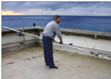
Aufbau der Vertikalantenne auf dem Hoteldach
