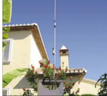
Bild 4: Montage der Antenne bei EA5AEF/DJ3VQ; die beiden Verlängerungsspulen und die Mantelwellendrossel am Fußpunkt sind gut zu erkennen. Fotos: DJ7BU
