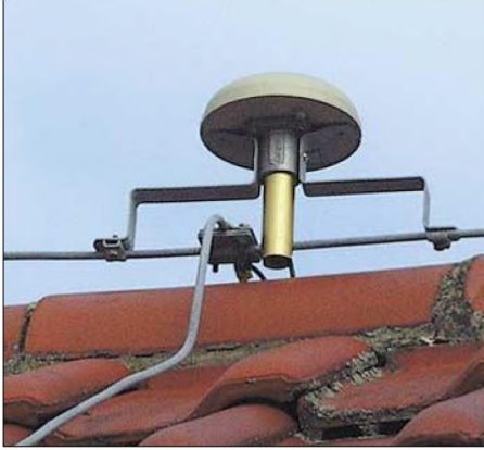
Bild 9: Ein exponierter Standort der GPS-Antenne sichert beständig ein optimales Referenzsignal. Die Montage erfolgte direkt am Blitzableiter auf dem Dachfirst. Fotos: DK6RX
