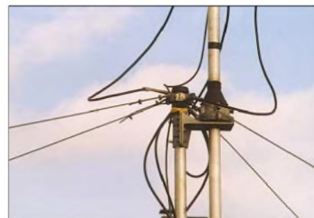
Bild 5: Abspannung des Tragwerks und Oberlager des vertikalen Tragrohrs
