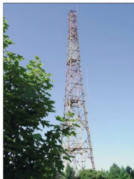
Antennenstandort von DO0SMS
