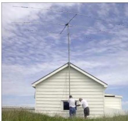
Beim Errichten des 3-Element-Beams
