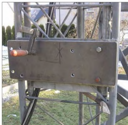
Zur Aufnahme der Winde muss eine etwas größere Stahlplatte mit der Platte am Mast verschraubt werden.
