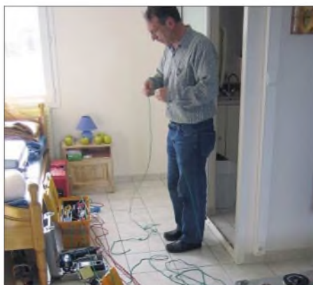
Letzte Vorbereitungen in Sachen Kabel
