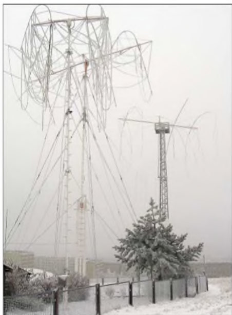
Wieder einmal schlugen die Unbilden des Winters in Ilmenau bei DA0HQ hart zu: vereiste Elemente richteten an diversen Quadantennen (u.a. 3-Element-Quad für 40 m im Bild rechts) schwere Schäden an. Foto: H. Weissleder
