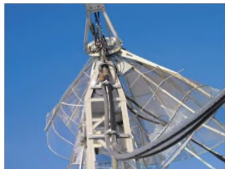
Am 20.1.06 büßte SK7MW den 4,5-m-Spiegel nach starkem Eisregen ein – somit ist NAC-Betrieb auf 13 cm nur eingeschränkt möglich. Foto: SM7EYW
