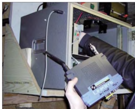
Einbau des WLAN-Routers
