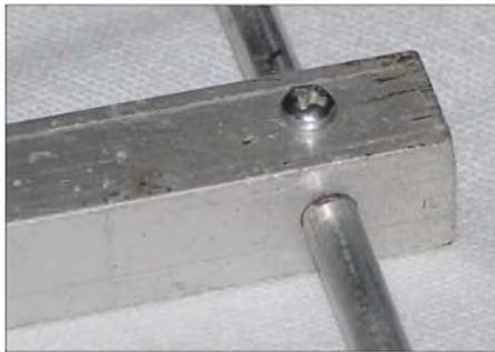
**Bild 3: Elementmontage von 4-mm-Rundstäben durch einen 10 x 10-mm<sup>2</sup>-Boom**
