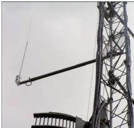
Die vertikal polarisierte 6-m-Halbwellenantenne bei EI0SIX Foto: EI7BMB
