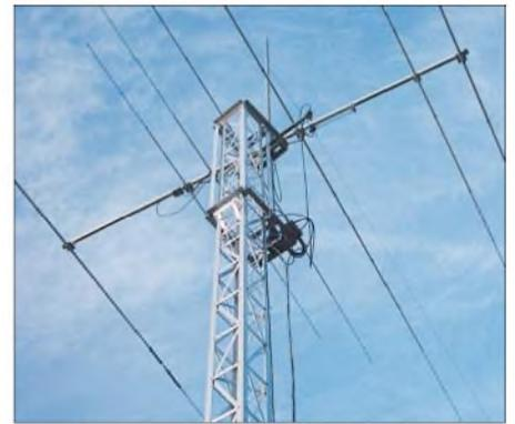
Bild 4: Einspeisung der FD5 mit 1:6-Balun
