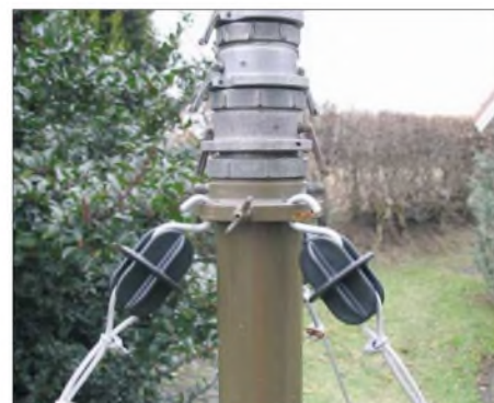
Bild 3: Mit Weidezaunisolatoren aus der Landwirtschaft kann der Mast abgespannt werden.
