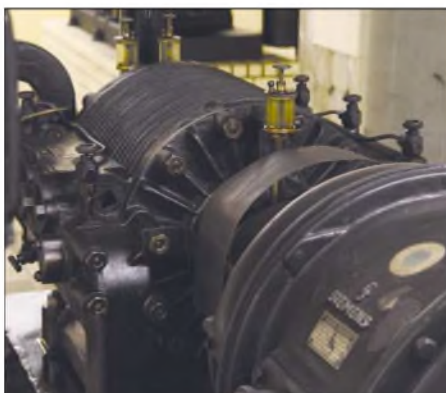
Bild 9: Gebläseapparate der Hausrohrpost im ehemaligen Haupttelegraphenamt Foto: Stefan Lehmann
