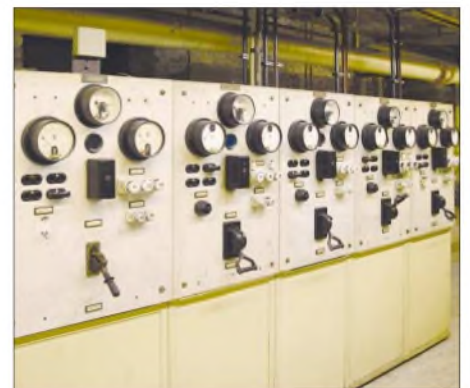
Bild 10: Noch erhaltene Rohrpost-Schalttafeln im Keller des ehemaligen Haupttelegraphenamts in der Oranienburger Straße Foto: Stefan Lehmann
