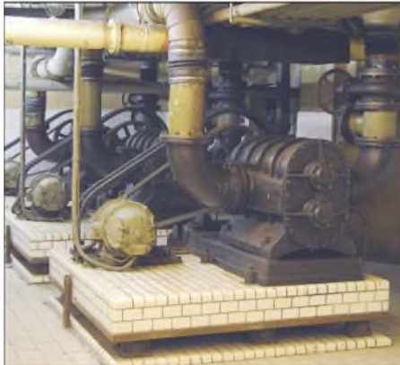
Bild 8: Gebläseapparate der Hausrohrpost im ehemaligen Haupttelegraphenamt Foto: Stefan Lehmann
