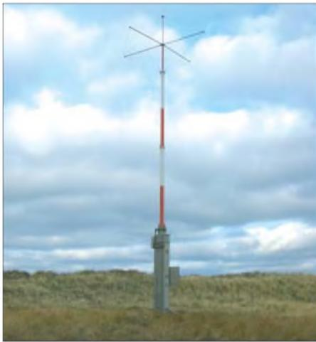
**Bild 1:** DGPS-Stationen senden GPS-Korrekturdaten auf Frequenzen um 300 kHz. Das Bild zeigt die Sendeantenne der Station Helgoland für 298,5 kHz.
