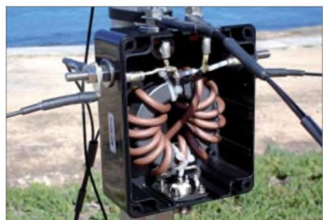
Die Einspeisebox des großen Spiderbeams
