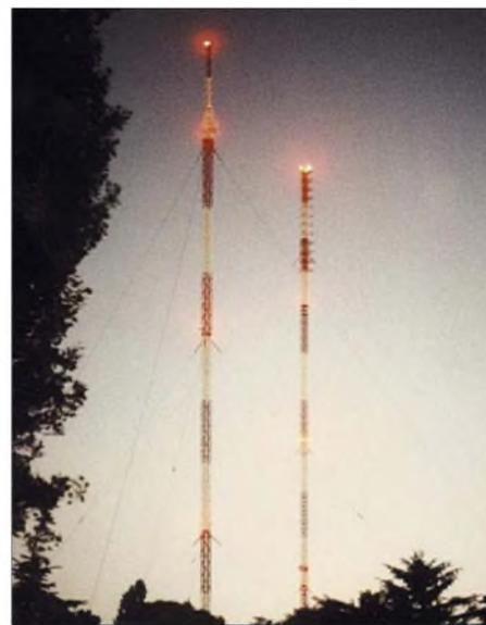
Die beiden selbststrahlenden Sendemasten der Sendeanlage Berlin-Britz: links der 144 m hohe Südostmast, rechts der 160 m hohe Nordwestmast.
