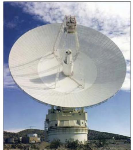
**Einst mit 64 m Durchmesser im Juni 1966 in Betrieb genommen und 1988 auf 70 m ausgebaut: Die erste der Antennen des „Deep Space Networks“ in Goldstone, Kalifornien, die schon bei den amerikanischen Mondlandungen Verbindung hielt. Dank rauschärmerer Empfänger schafft sie es inzwischen bis zu den Planeten.**
