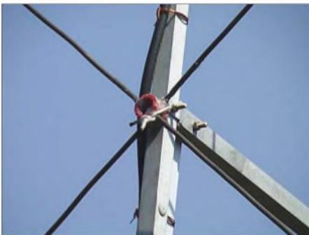
**Bild 13:** Konstruktive Lösung der Leitungskreuzung durch einen Abstandshalter aus einem geschlitzten Kunststoff-Rohrstück
