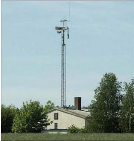
Bild 1: Drehbarer Peilerkopf auf 20-m-Gittermast
