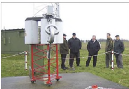
Bild 2: Spezialtransformator für die Befeu- rung (rote Warnleuchte) der Antennenspitze
