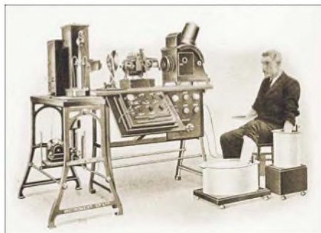
Bild 1: Beim ersten EKG-Gerät mussten Hände und Beine noch in Gefäße mit Salzwasser eingetaucht werden. Heute reichen Elektroden mit leitfähigem Gel. Quelle: [1]
