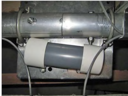
Bild 9: Entweder man dreht die rechte Schraube um 180° oder bohrt neu.
