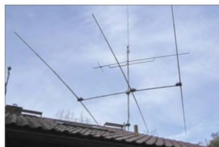
Bild 17: Aufgebaute Antenne 2 m über Dach
