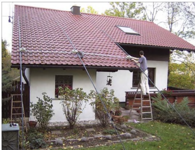
Bild 1: Die fertige Antenne vorm Aufstieg zum Mast
