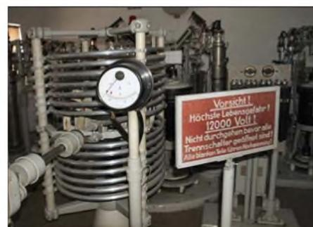
**Bild 15: 100-kW-Mittelwellensender Hamburg Billwerder-Moorfleet Fotos: DL2MCD**
