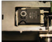
Bild 2: Widerstand 50 Ω/100 W im eingebauten Zustand
