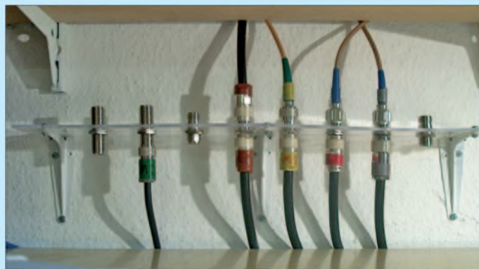
Bild 2: Der an Konsolenträgern montierte Plexiglasstreifen dient zur potenzialgetrennten Montage aller im Shack endenden koaxialen Speiseleitungen. Zuwachs ist bereits eingeplant.
