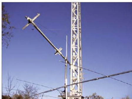
Bild 4: Für die 20-m-Elemente wurden große Haltekreuze genutzt.
