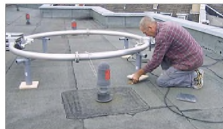
Bild 2: Liegende Montage der Magnetschleifenantenne Fotos: DL2KDK
