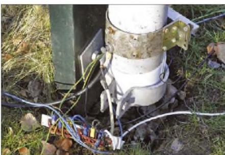
**Bild 6:** Isolation des Kurbelmastes gegen Masse
