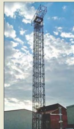
Mit den auf dem WiMo-Firmengelände vorhandenen Masten lassen sich die Kelemen-Antennen in ausreichender Höhe über Grund vermessen.
