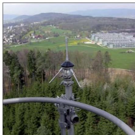
Die 70-cm-Antenne der Relaisfunkstelle HB9SP/D in der Nähe von Zürich (JN47GJ). Foto: HB9SP
