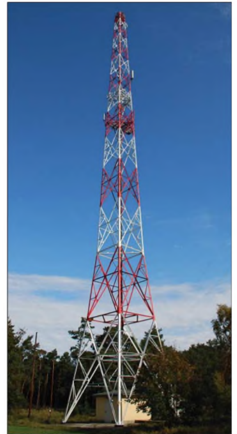
Bild 3: 70 m hoher Antennenträger; die Ionosonde befindet sich in dem Häuschen auf dem Mastsockel
