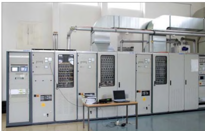
100-kW-Mittelwellensender für 990 kHz
