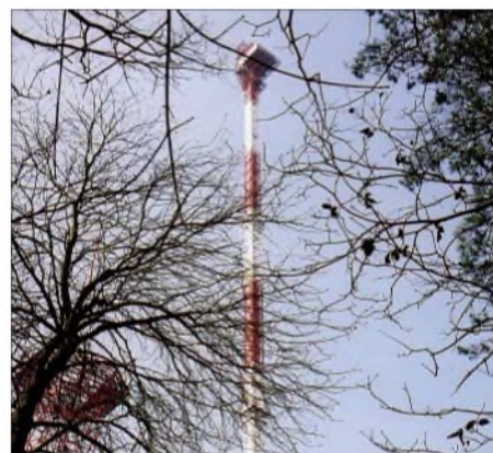
Die 24 m hohe Vertikalantenne für Mittelwelle in Berlin-Frohnau
