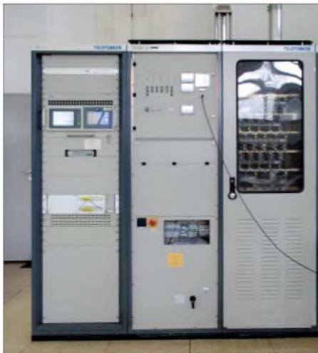
DRM-Sender (14 kW) für 855 kHz
