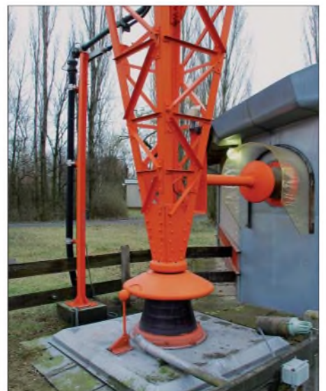
Fuß des 160 m hohen Nordwest-Mastes
