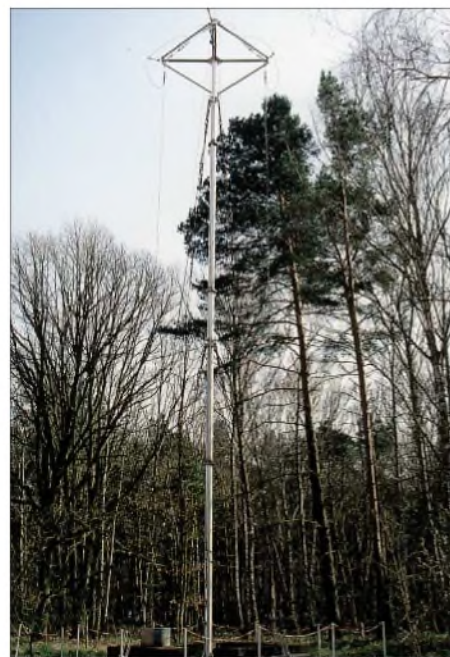
Die 24 m hohe Vertikalantenne für Mittelwelle in Berlin-Frohnau
