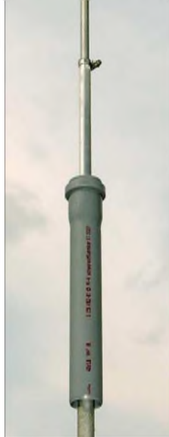
Bild 9: Das übergeschobene HT-Rohr schützt den Sperrkreis.
