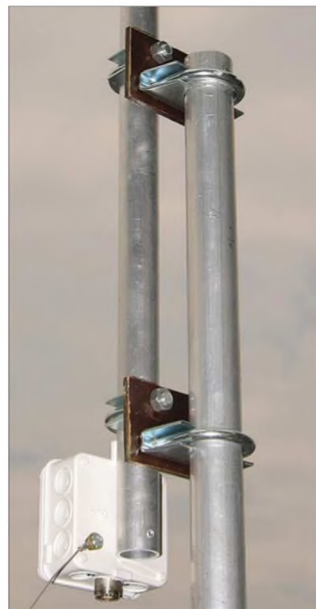
Bild 8: Isolierte Halterung für die Befestigung des Strahlers am Mast
