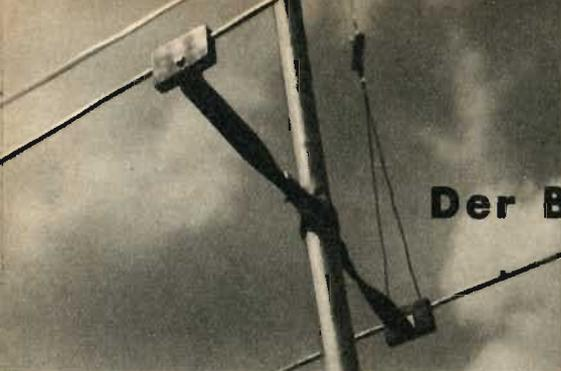
Abb. 1. Abstandsträger für Dipol und Reflektor und seine Befestigung am Antennenmast
