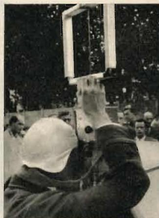
Links: Besonders emsig betätigte sich DL 3 SI an seinem 80-m-Gerät, das nicht nur vollständige Seitenbestimmung ermöglicht, sondern auch mit angebautem Kompaß sofort eine Standlinie liefert. Rechts: DE-Anw. Tautim benutzt gleichfalls einen 1-V-1 mit abgestimmter Rahmenantenne und eingebauten Batterien in seinem 80-m-Peilergerät (Aufnahmen: C. Möller)
