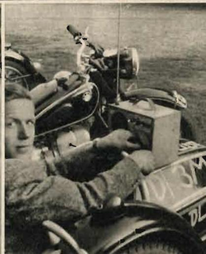
Oben: Der batteriebetriebene Sendempfangsgeräten von DL 3 MO arbeitet auf dem 80-m-Band, benutzt die Röhren P 700, RL 2,4 T 2, P 800 und gestattet Lautsprecherempfang
