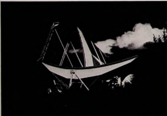
Bild 1. Seitenansicht der aus einem in vier Segmente unterteilten Zylinderausschnitt bestehenden UHF-Antenne für das EISCAT-Projekt. Am vorderen Segment ist der in waagerechte Lage geschwenkte Reflektor und links darüber die gedeckte Antennenbrücke zu erkennen.
