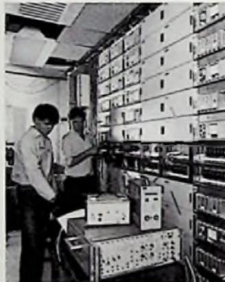
Bild 1: Einmessen der Sende- und Empfangseinrichtungen im Fernmeldeturm (TE KA DE/PKI-Pressbild)
