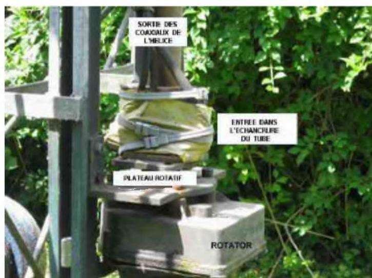
Détails du bout du tube porte-antennes. On y a fixé l'antenne omnidirectionnelle pour 144/432/1200 Mhz. On peut y voir la sortie des divers câbles coaxiaux qui vont vers les antennes respectives.
