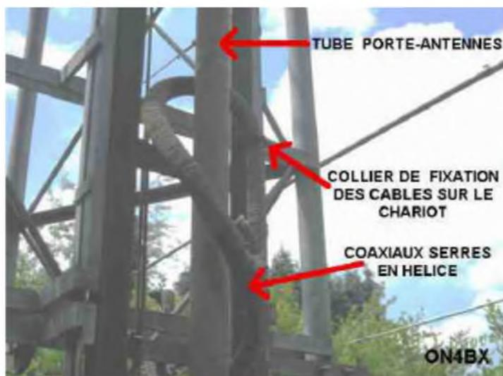
Le tube porte -antennes est rotatif et est fixé à sa base au plateau du rotobrake. il comporte à sa base deux échancrures pour laisser passer tous les câbles coaxiaux. Tous ces câbles montent à l'intérieur du tube et ressortent pas son extrémité supérieure. De là, ils redescendent vers les antennes.
