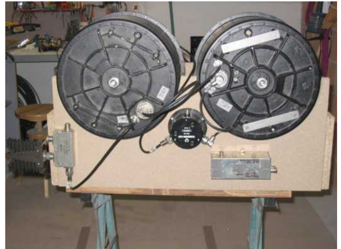
Vue avant côté passe-bas : A gauche, l'isolateur Tx avec sa charge poubelle. Au centre le circulateur de couplage antenne. A droite un duplexeur UHF /VHF pour le couplage à une antenne verticale bi-bande.
