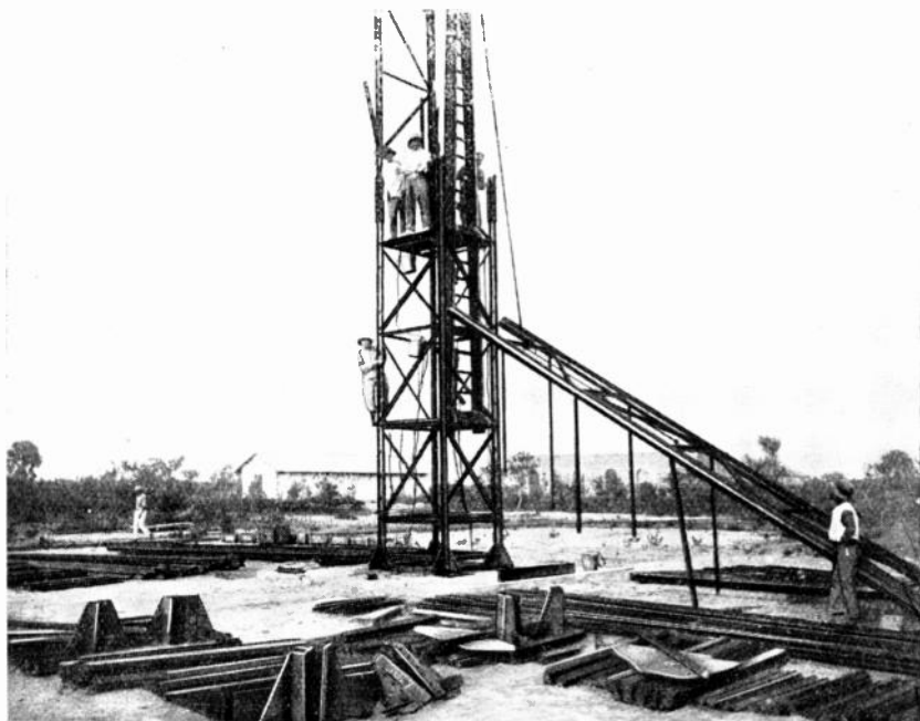
Fig. 3. — Montage d'un pylône de 150 mètres à Brazzaville.
