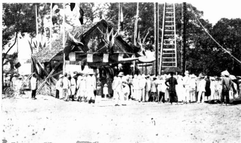
Fig. 10. — Pose du premier boulon des pylônes du poste de Saïgon, en présence du maréchal Joffre.
